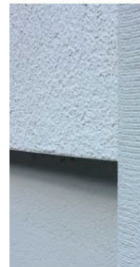
Unterschiedliche Putzstruktur
