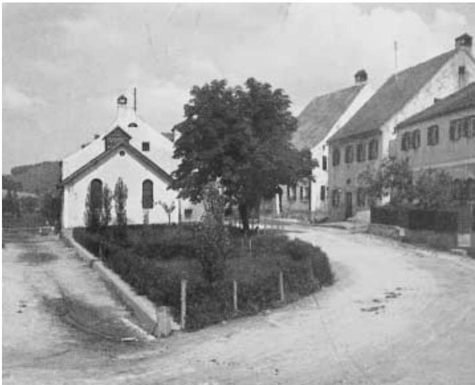
Kommunbrauhaus in Kallmünz (1938). Im Jahr 1941 stellte das Brauhaus den Betrieb ein. 1957 wurde es wegen Straßenerweiterung abgebrochen
